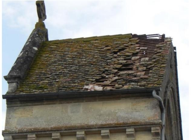
C'est l'église qui a subi les plus lourds dommages. Il va être nécessaire de refaire la toiture du clocher, ainsi qu'une partie de la toiture de la nef, endommagée par la pierre pignon qui est tombée. Pour le moment, l'électricité n'a pas pu être rétablie dans l'église. Ce bilan n'est peut-être que provisoire, en espérant que le moteur des cloches n'ait pas été atteint.
