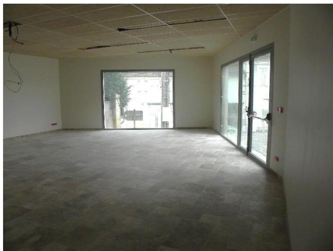
Les travaux de la Mairie se poursuivent depuis 18 mois. Ils sont en train de toucher à leur fin. A l'intérieur, les carrelages de travertin sont posés, les doublages et isolation sont en place, les peintures des murs et des plafonds sont terminées, les sanitaires et chauffages sont posés. Bref, les finitions sont en cours.
